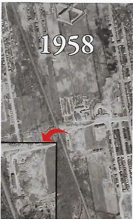
1958 La carrière Parent comblée peu avant l'extension du boulevard Henri-Bourassa Ouest vers Ville Saint-Laurent
