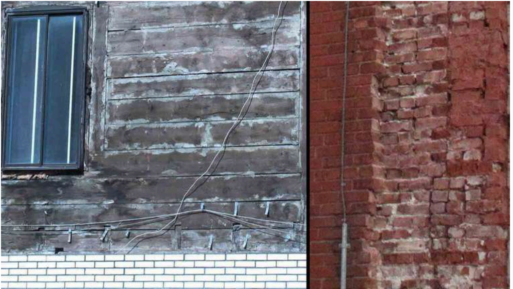
Figure 5.10 Deux types de construction bien différents : à gauche, presque toutes les briques de parement ont été arrachées pour laisser voir le carré de madriers; à droite, on a enlevé plusieurs briques du premier rang d'un assemblage de briques porteuses.
