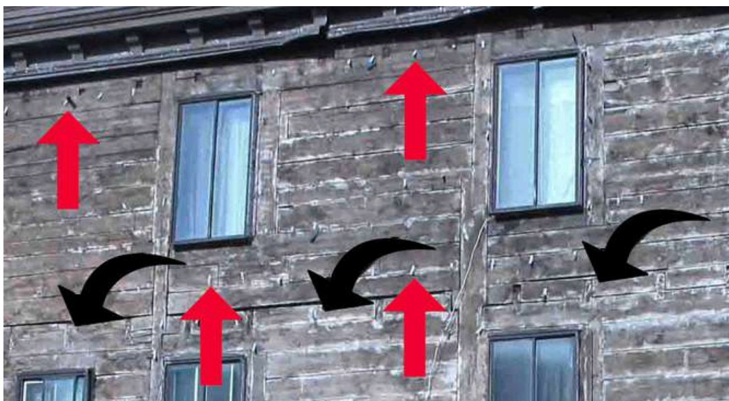
Figure A.2 Une section d'un carré de madriers rue Saint-Laurent; photographie des auteurs.
